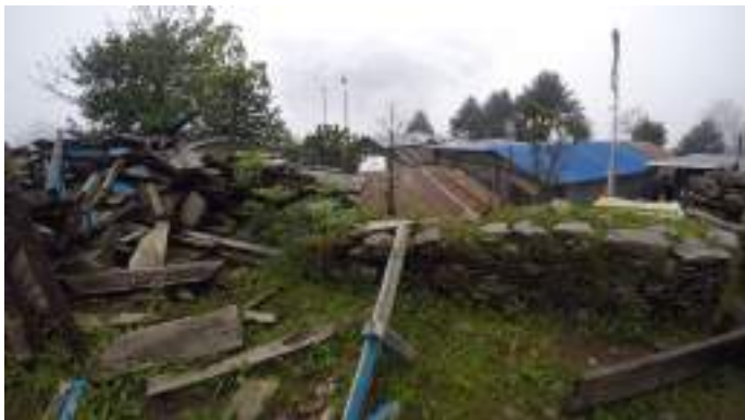
Schade aardbeving Tarkeghyang
