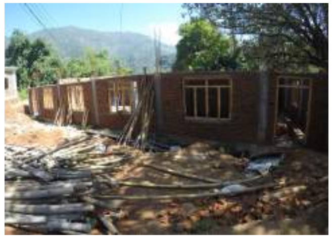
Toekomstig hostel gebouw Shree Ramrika
